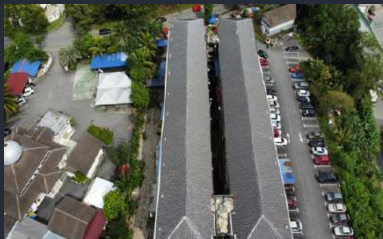
BUMBUNG BLOK C DAMAI COURT
